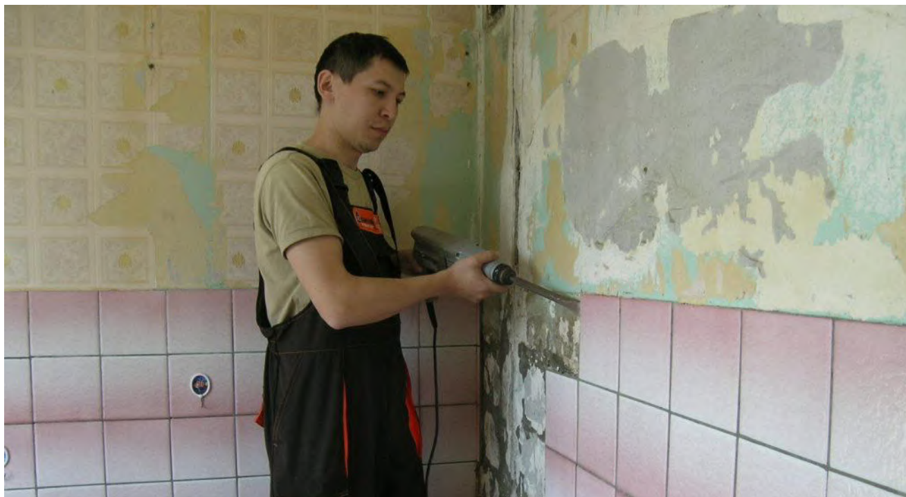
Демонтаж плитки со стены перфоратором с плоской лопаткой.
