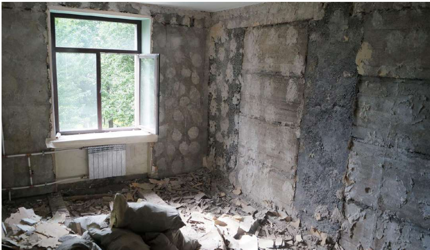
Примерно так выглядит начальный этап ремонта.
