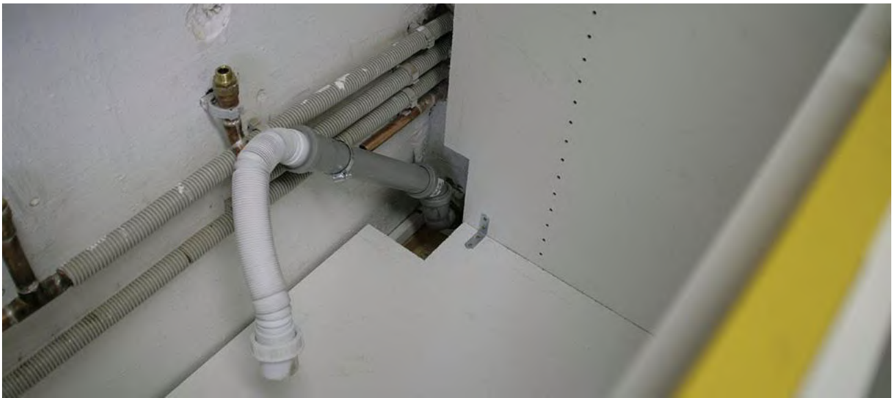
Перенос мойки медными трубами в пластиковой гофре.
